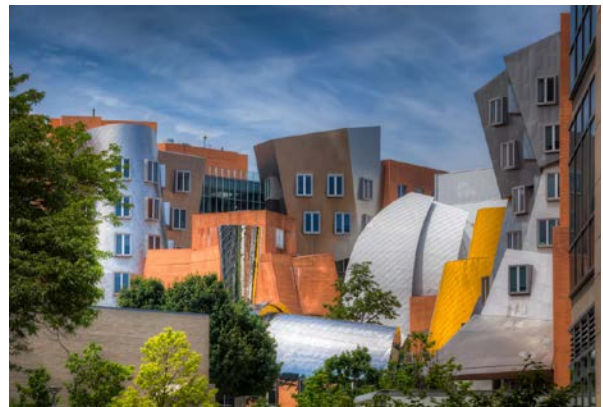
La sede del centro di studio sull'intelligenza artificiale del MIT è ospitata nello State Center progettato da Gehry.
