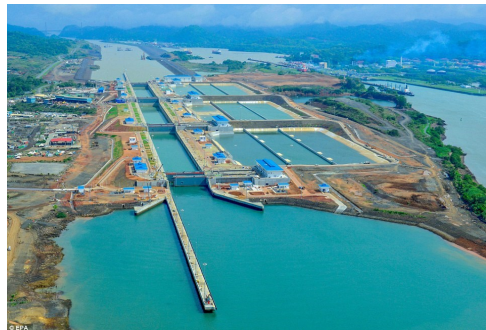
Chiuse e bacini lungo il canale di Panama.
