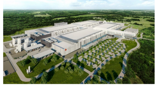
Fabbrica di chip Texas Instruments in costruzione in Texas
