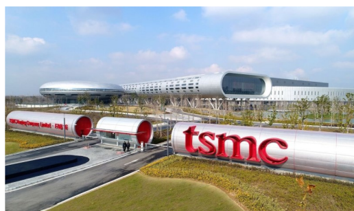
Fabbrica di semiconduttori Tsmc in costruzione in Arizona
