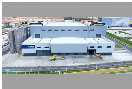
Il grande impianto Basf in costruzione a Zhanjiang. Cina
